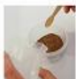
Wypełnianie ubytków i dziur w drewnie i materiałach drewnianych.
