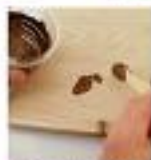
Szlifowanie szpachli po wyschnięciu.
